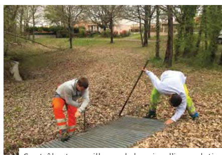
Contrôle et surveillance de bassins d'inondation
