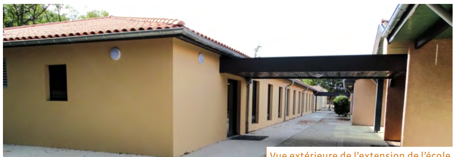
Vue extérieure de l'extension de l'école.
