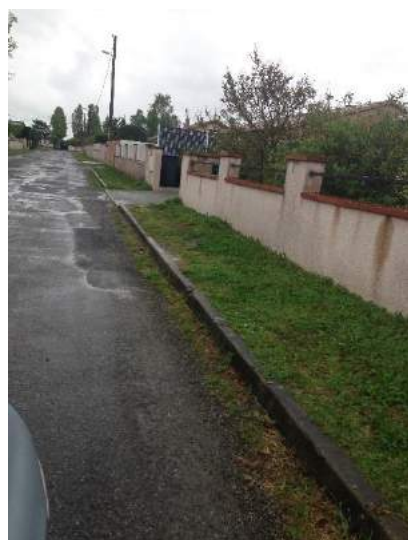
Trottoir à réaménager
